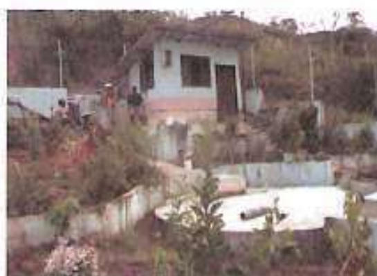
Planta De tratamiento del agua potable
