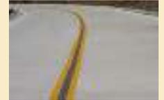
**Resistencia al deslizamiento.** Al igual que la carpeta de rodadura, la señalización debe presentar una resistencia al deslizamiento suficiente para que los vehículos circulen sobre ella sin riesgo. Esta condición está directamente relacionada con su coeficiente de fricción, ya que la resistencia al deslizamiento es producto de ese coeficiente por la fuerza normal que ejerce el vehículo al pasar sobre la señalización.
