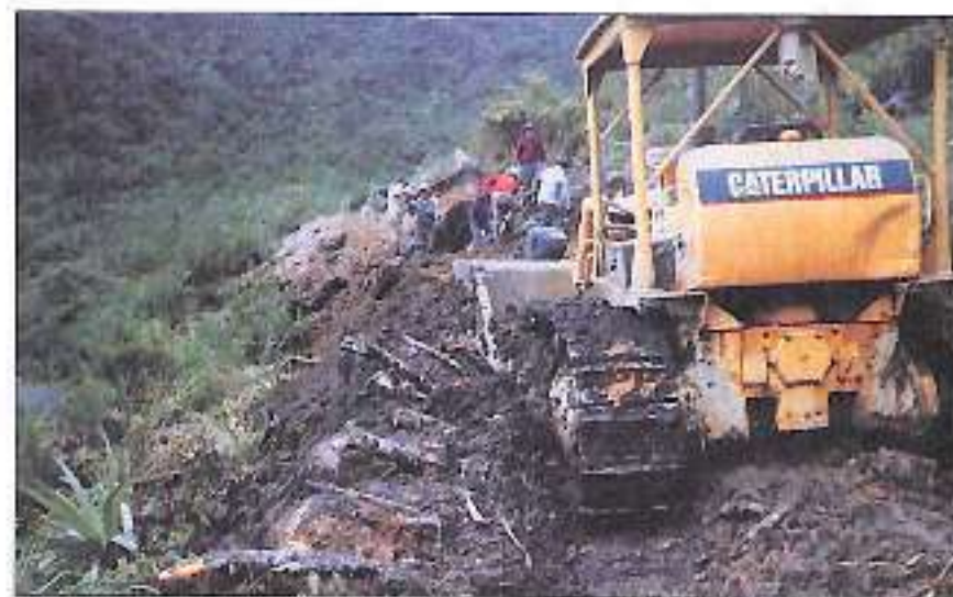
Trabajos en el camino agrícola Gima - Amazonas
