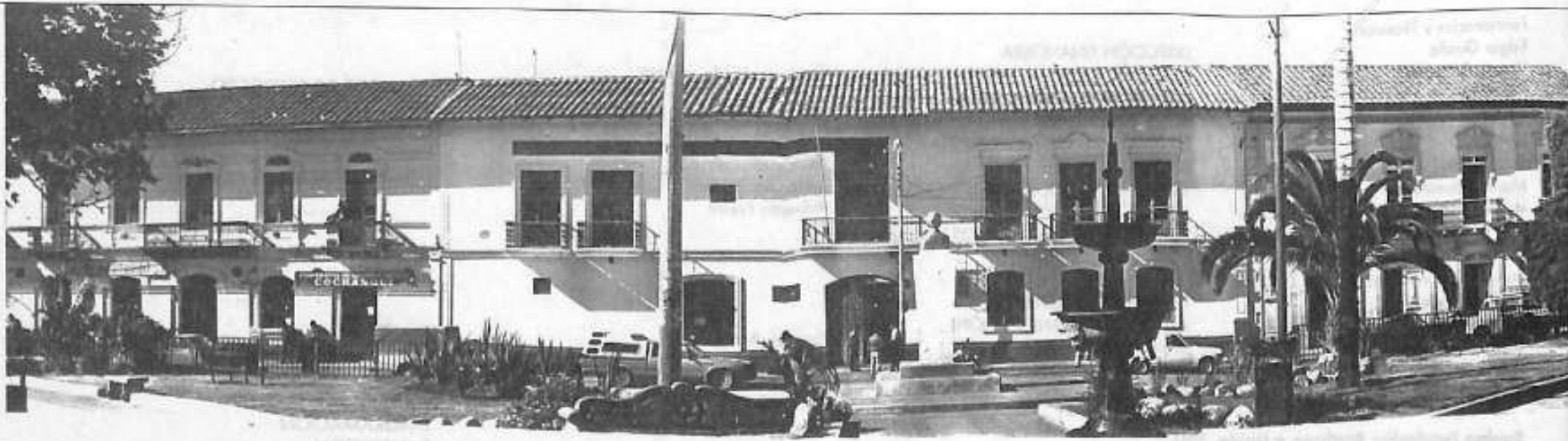
Edificio del Municipio del Cantón Pedro Moncayo
