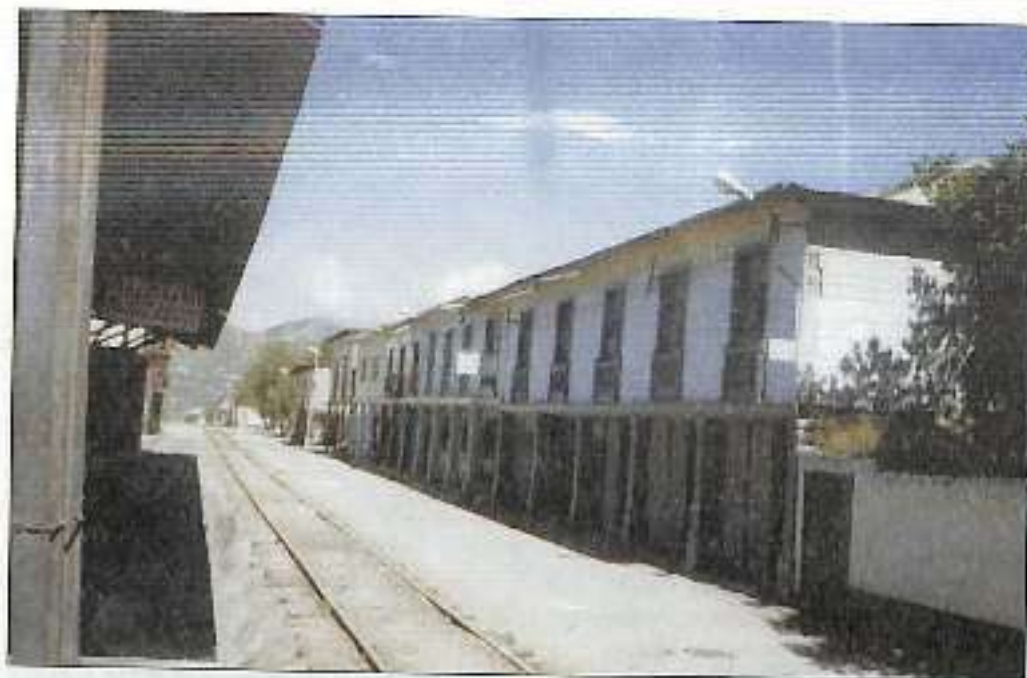
Vista de las edificaciones de principio de siglo, frente a la Estación del Ferrocarril en Alausí
