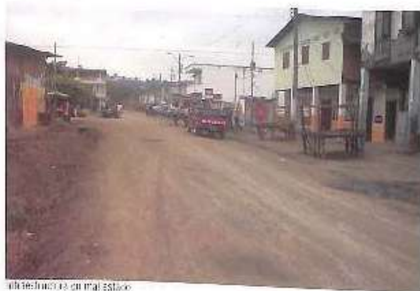
Infraestructura en mal estado
