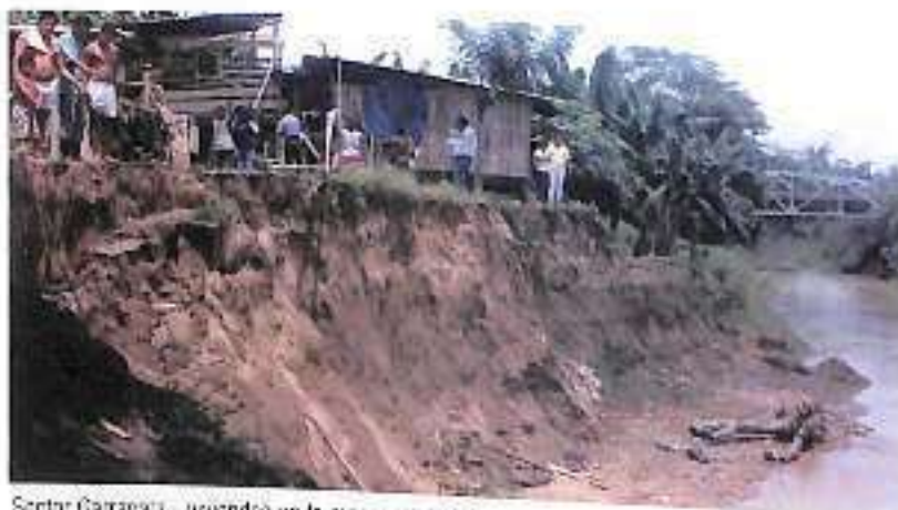
Sector Garrapata - viviendas en la margen del río
