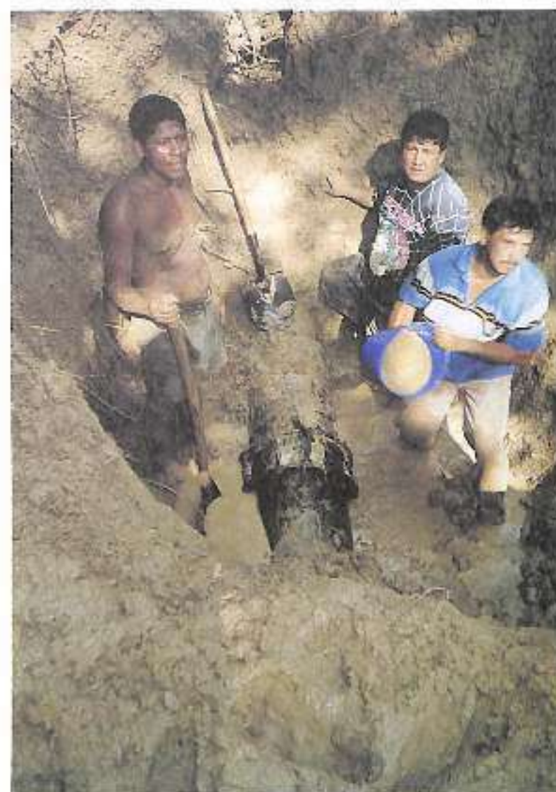
Construcción de las tuberías de conducción de agua.
