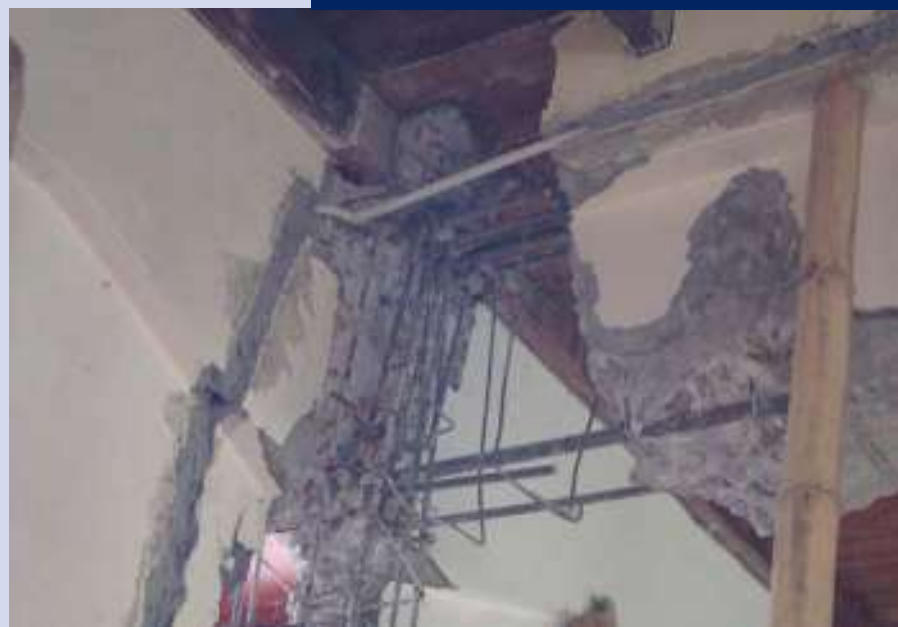
Hierros desgastados y oxidados en la estructura de hormigón amenazaban la estabilidad del inmueble
