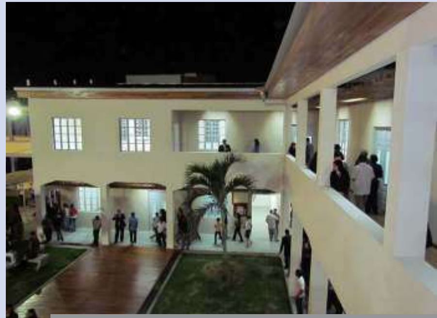
A la derecha de la parte posterior del edificio intervenido y recuperado
