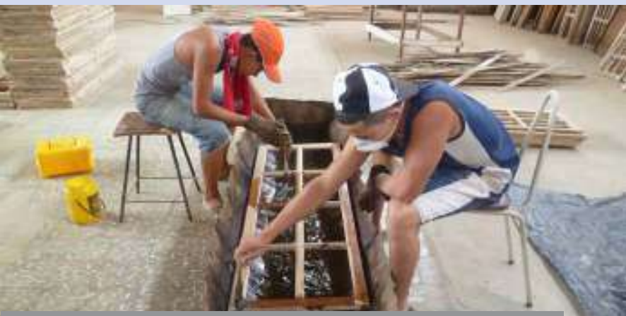
Proceso de consolidación de elementos de madera
