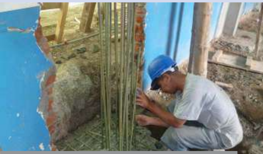
Se reforzaron las columnas del edificio utilizando material antisísmico
