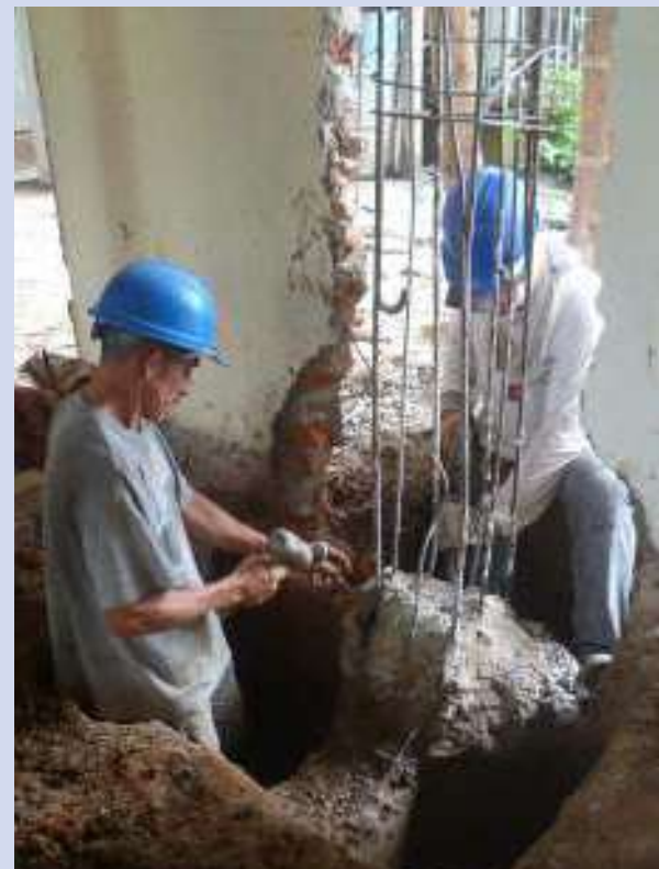
Hierros desgastados y oxidados en la estructura de hormigón amenazaban la estabilidad del inmueble
