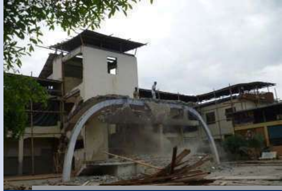
Liberación de paredes en el bloque de escaleras
