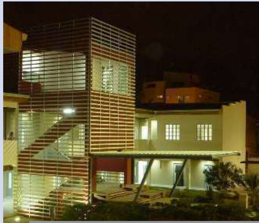
Se implementó un sistema de celosías de aluminio en el área de escaleras para mejorar la ventilación del edificio
