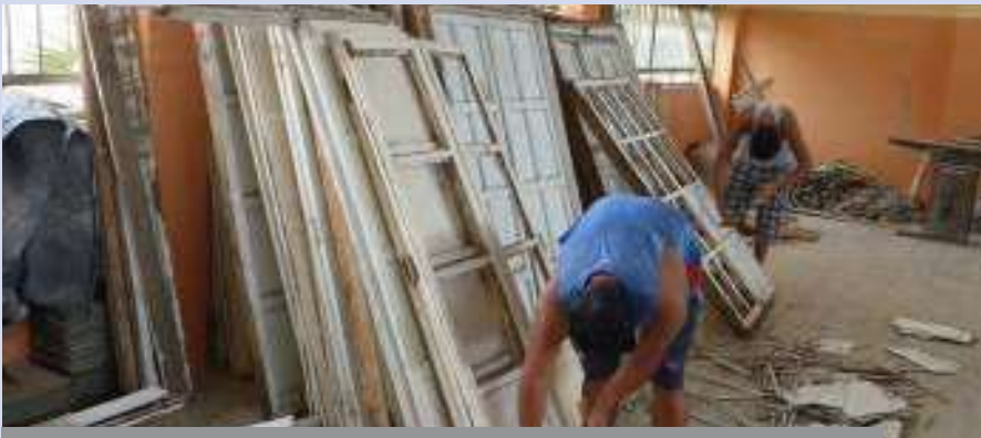
Retiro de los vidrios de puertas y ventanas
