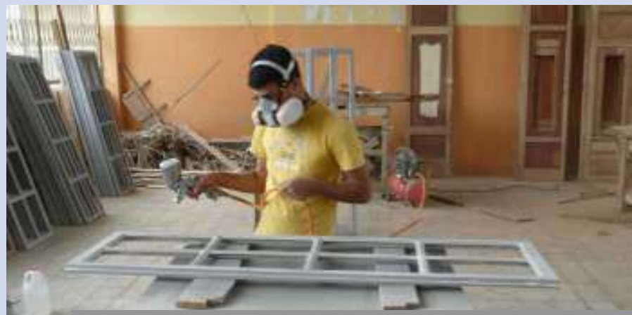
Acabado final de las ventanas
