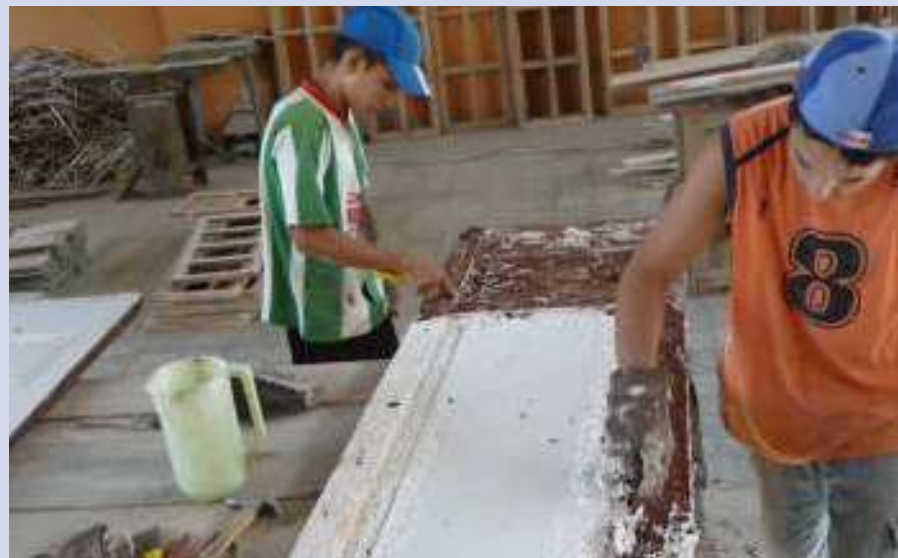
Remoción de pintura de las ventanas
