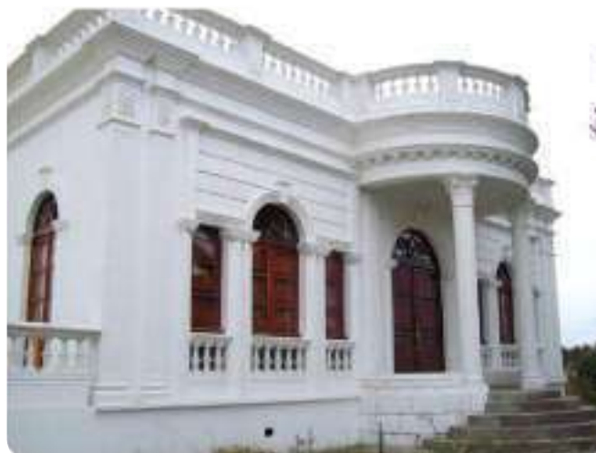
Casa Aranjuez, provincia de Cotopaxi. Después de la intervención. Fuente: Ministerio Coordinador de Patrimonio.
