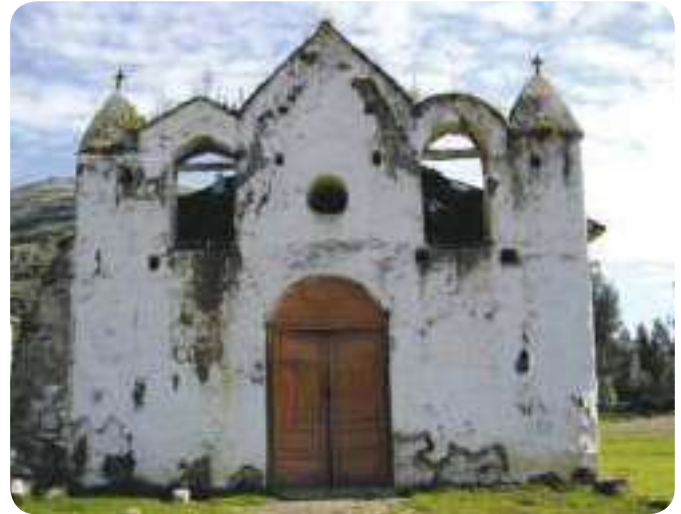
Capilla de la Moya, provincia de Chimborazo. Antes de la intervención. Fuente: Decreto de Emergencia del Patrimonio Cultural.
