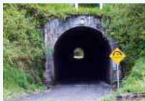
Túnel Agoyán, Baños.
