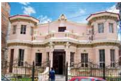
Inmueble de la ciudad de Riobamba
