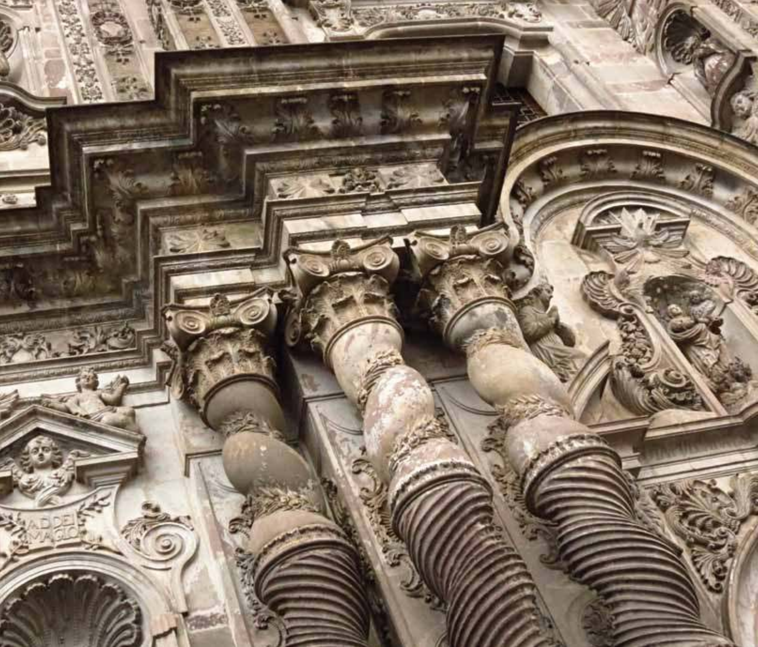
Detalle de fachada de la iglesia de La Compañía de Jesús, Quito
