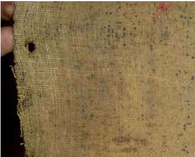
Orificios en el perímetro del soporte
