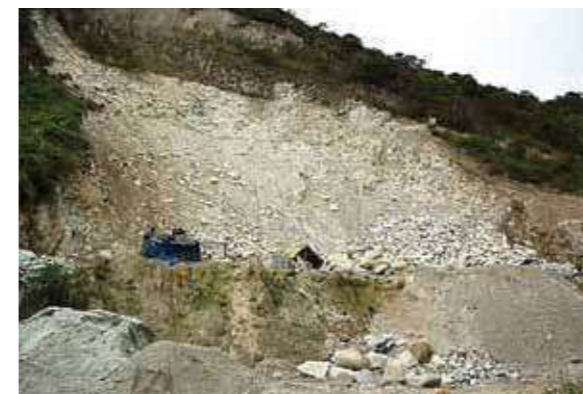
Derrumbe en la cantera de Saraguro
