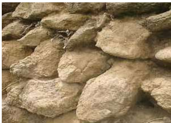
Pared con bloques de cangahua, Chimborazo
