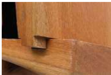
Unión machihembrado
