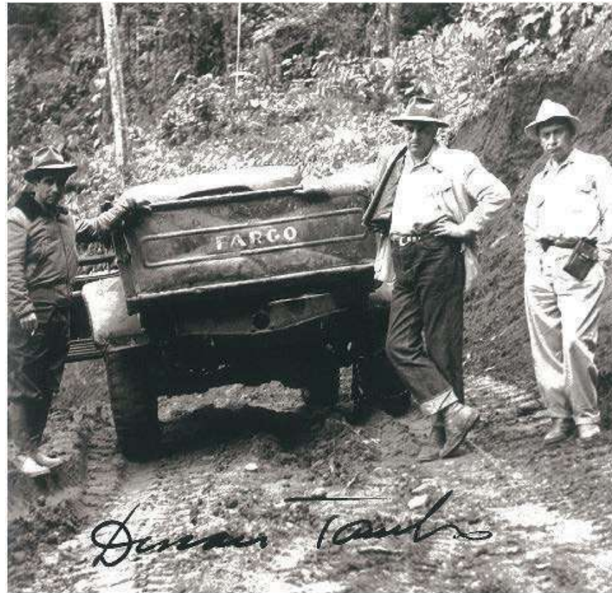
Cielo Plaza, como presidente, durante la construcción de la vía Durán Tumbaco, s.f.
