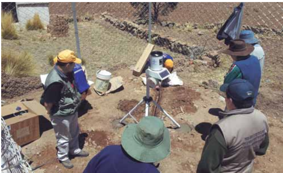
Instalación de una estación agrometeorológica telemétrica.
