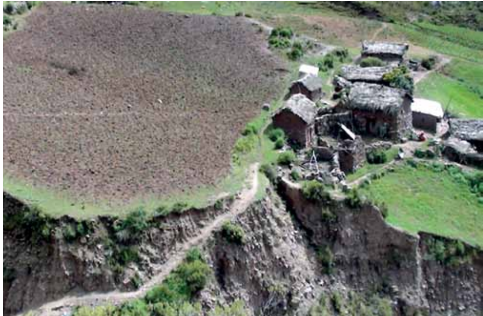
Cultivos y viviendas precarias construidas en áreas altamente expuestas a deslizamiento en la Región Andina de Cochabamba.
