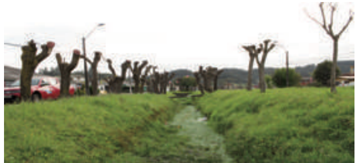
Descripción: Canal Obstruido por vegetación. Territorio Las Higueras.
