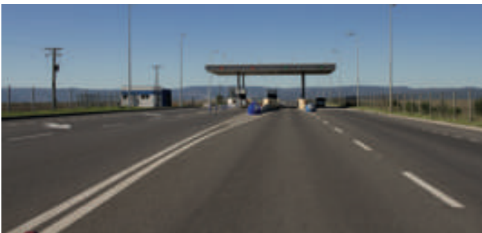
Descripción: Peaje enlace Rocuant, Ruta Interportuaria.
