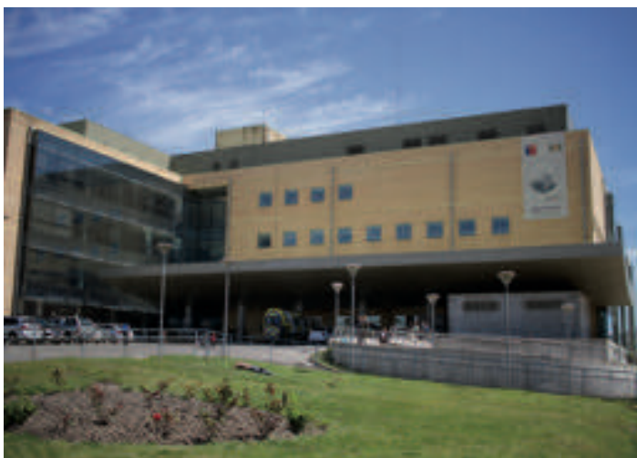
Descripción: Hospital de Alta Complejidad Las Higueras.
